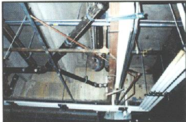
Mantenimiento de Edificios
